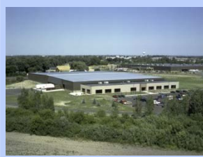
Holland, Michigan USA Li-Ion production
